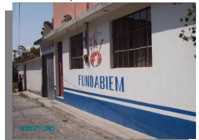
FOTO No. 41 Vista acceso FUNDABIEM
