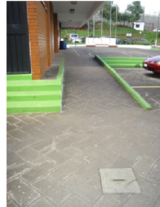
FOTO No. 2 Utilización de rampas de Acceso + Textura en caminamientos.
