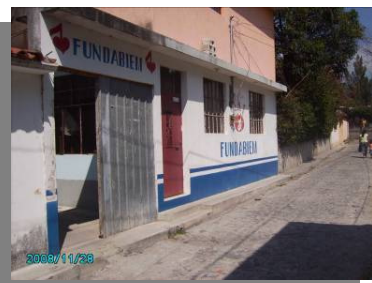
FOTO No. 37 Vista acceso FUNDABIEM
