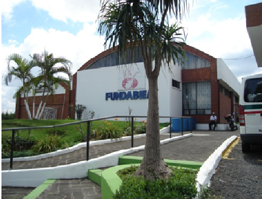
FOTO No. 1 Acceso Principal.
