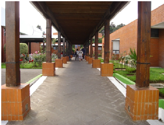
FOTO No. 3 Pasillo de Ingreso. Utilización de Columnas de Madera +Terraza Española como cubierta.
