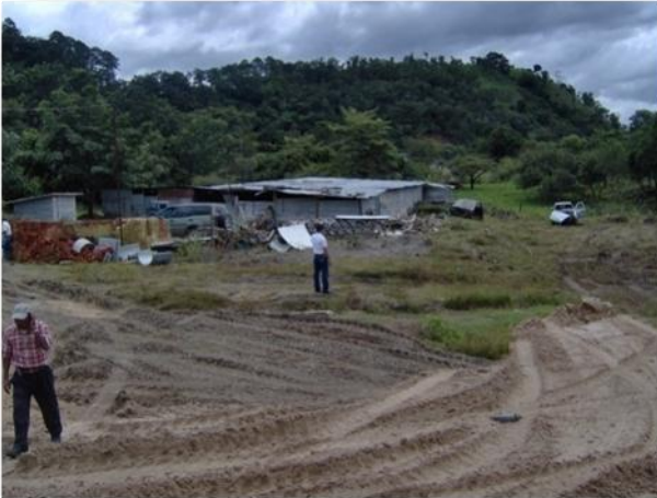
IMAGEN 19: Terreno a intervenir Fuente: propia del trabajo de campo
