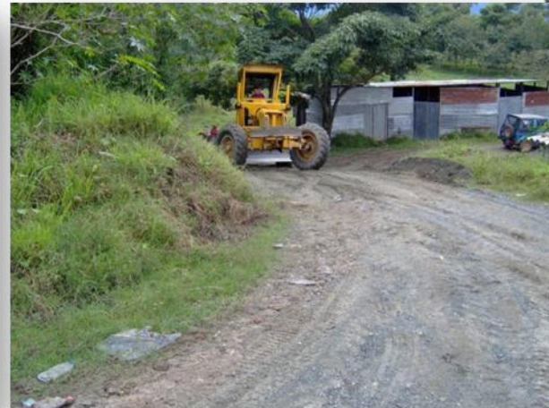
IMAGEN 22: Terreno a intervenir. Fuente: propia del trabajo de campo
