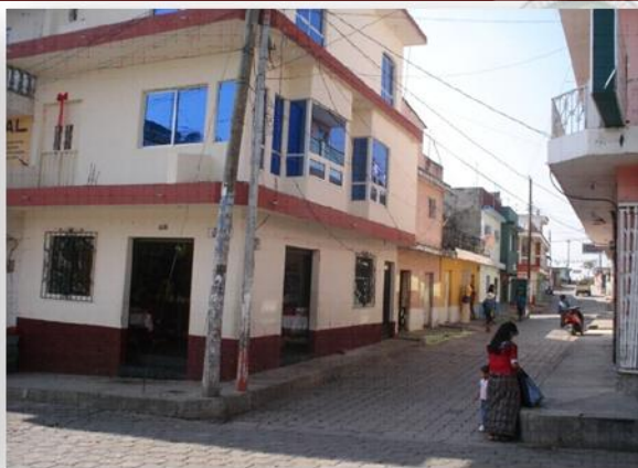
IMAGEN 4: Ave. Las Buganvillas Fuente: Propia del trabajo de campo
