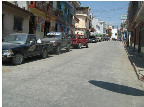
IMAGEN 14. Calle Las Flores Fuentes: Propias del trabajo de campo
