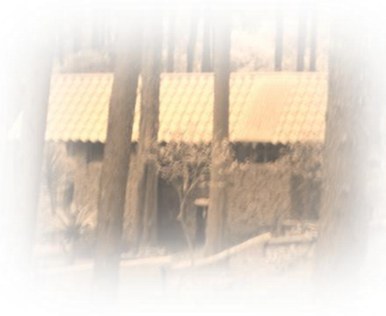
FOTO No. 19 Servicios Sanitarios FUENTE: Visita de Campo Parque La Cerra
