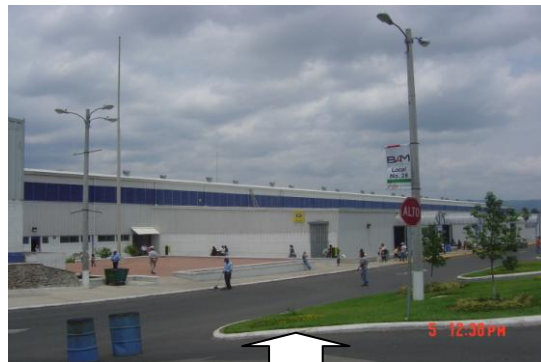
Fotografía No. 6. Mercado Municipal del Municipio de Villa Nueva, Guatemala.
