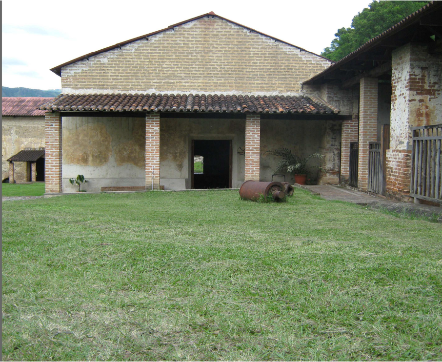
F-5 SALA DE SACADO
