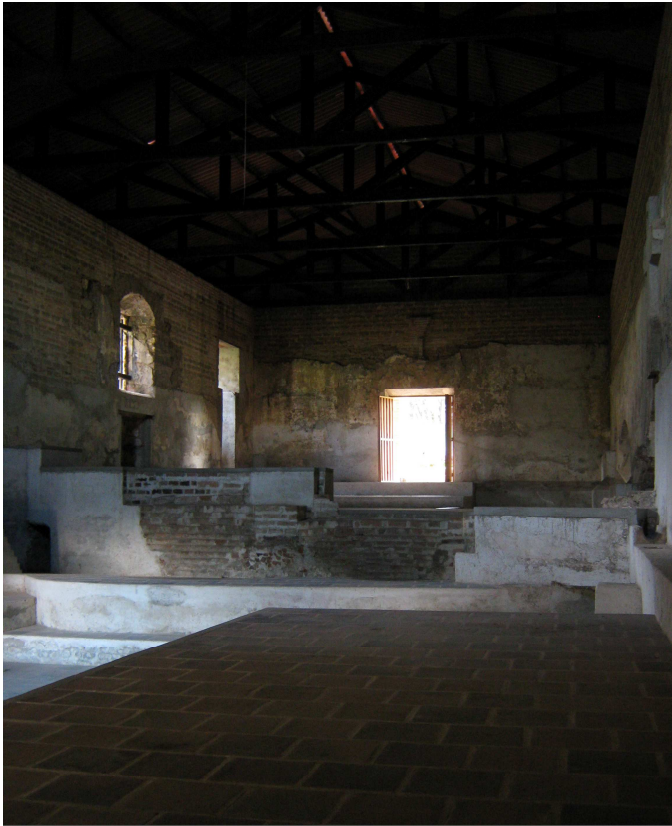
F- 19 - SALA DE SECADO TECHADA
