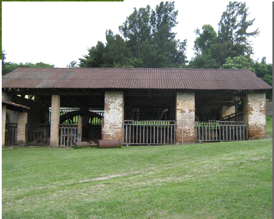
F-4 - SALA DE MAQUINAS
