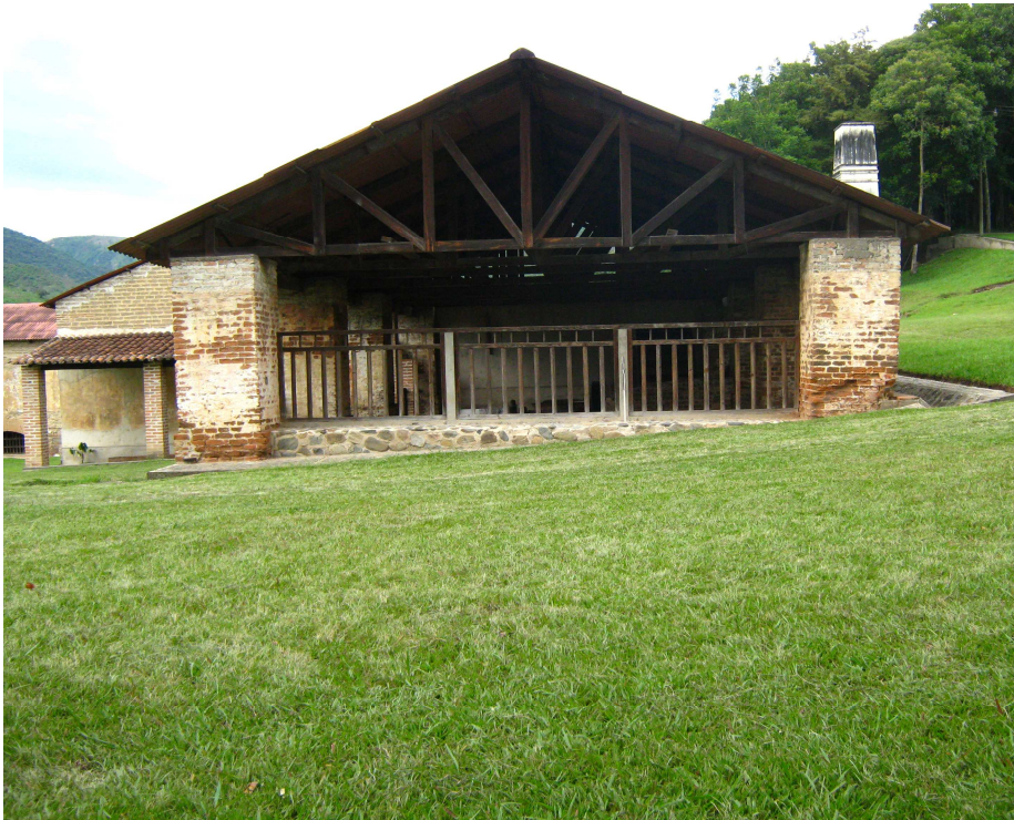
F-2 - SALA DE MAQUINAS
