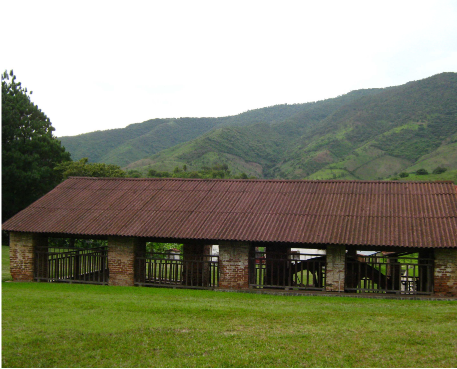
F-1 - SALA DE MAQUINAS
