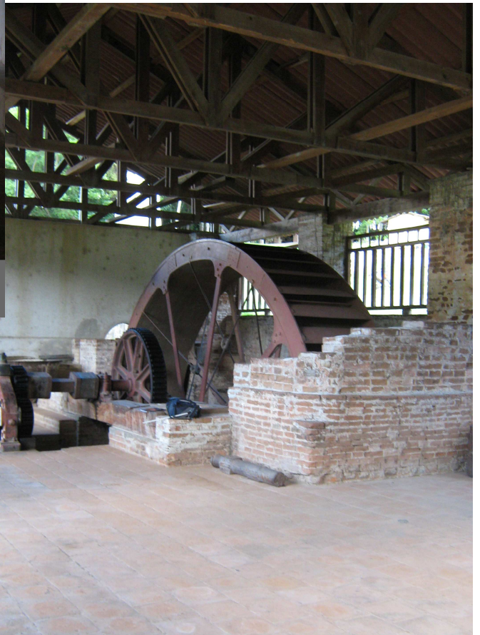
F- 20 SALA DE MAQUINAS
