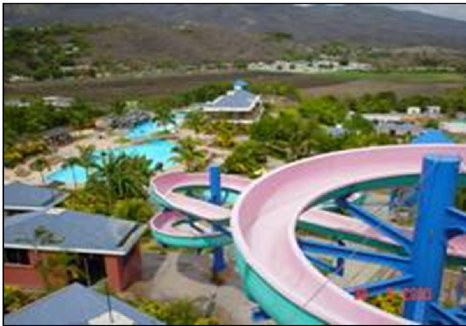
FOTOGRAFÍA No. 7 Área Recreativa (Piscinas)
