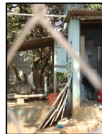
Existen con un tanque de sedimentación y una planta de tratamiento para la colonia
