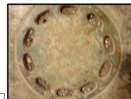
● Cajas de drenajes de aguas negras al centro de los salones, donde se localizan los locales comerciales.
