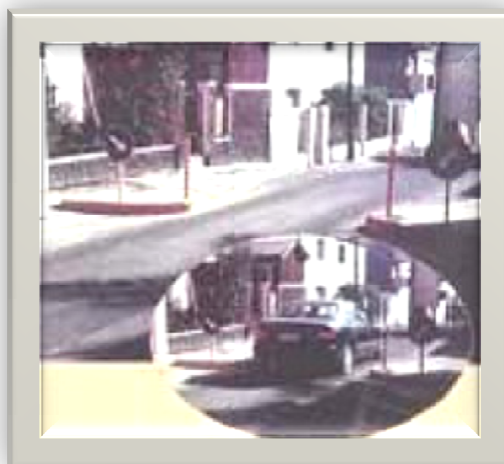
Foto 30. Restrictores de ancho
