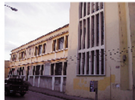
Detalle de la fachada de la biblioteca, con volúmenes y ventanas del tipo art déco, que se elevan sobre el nivel del terreno. Se observan los volúmenes que se elevan sobre el nivel del terreno.
