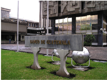
Imagen No. 10. Banco de Guatemala. Fuente: Dr. Samuel Vergés, DG, USAC
