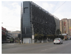
Edificio Granai & Townson.
