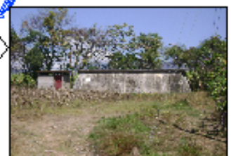
Planta de tratamiento de agua potable, desde donde se distribuye hacia el casco urbano.
