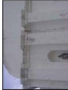
Fotografía No.2 Falta de material, erosión y desprendimiento de muro de fachada oeste del Templo Católico de Santa Cruz la Laguna.
