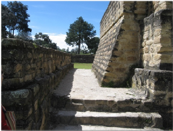
Fotografía No. 34 Pasillo entre Edificio 1 y 13, Grupo B. 80
