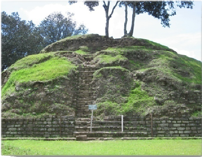
Fotografía No. 42 Edificio 5, grupo C. 88
