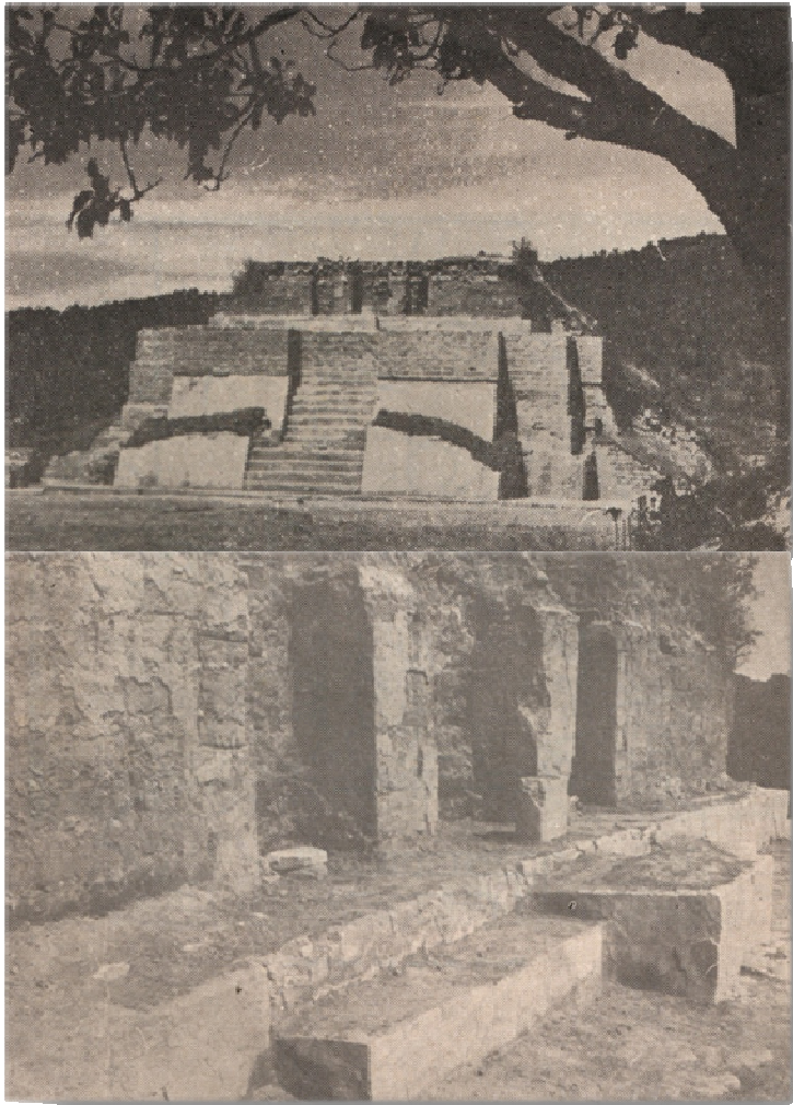
Fotografía No. 6 Templo 2, restauración parcial 39
