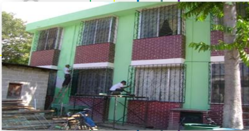
Imagen 29: fachada posterior del Salón Municipal.
