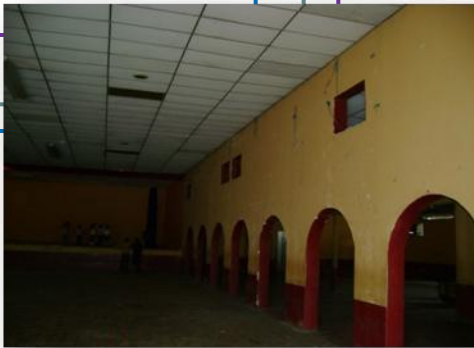
Imagen 5: interior del Salón Municipal Rabinal.
