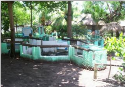
Instalaciones actuales del recinto de animales en peligro de extinción (Centro de visitantes USAC).
