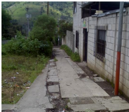
Fotografía 4: Callejón con recubrimiento de cemento
