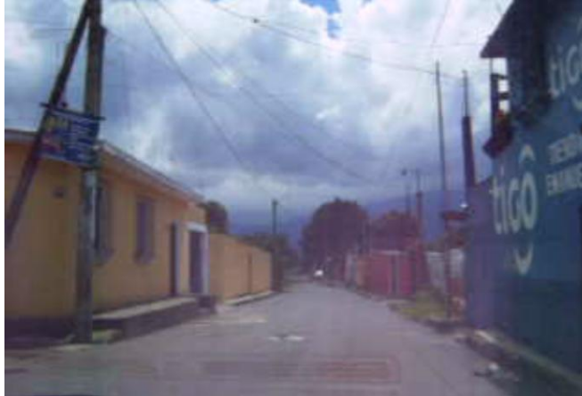
Fotografía No. 18 Rasgos arquitectónicos coloniales
