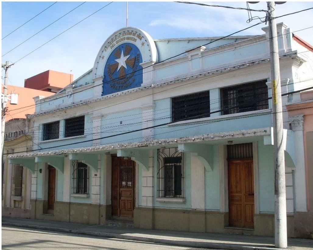
FOTOGRAFÍA DEL ESTADO ACTUAL DE LA FACHADA DEL SALÓN LAS LUCES
