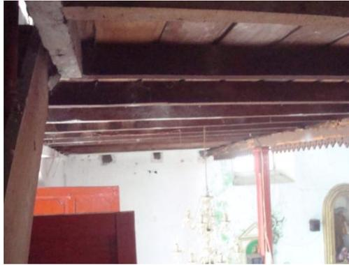
**Fotografía 31:** vista de las vigas de madera que soportan el coro alto
