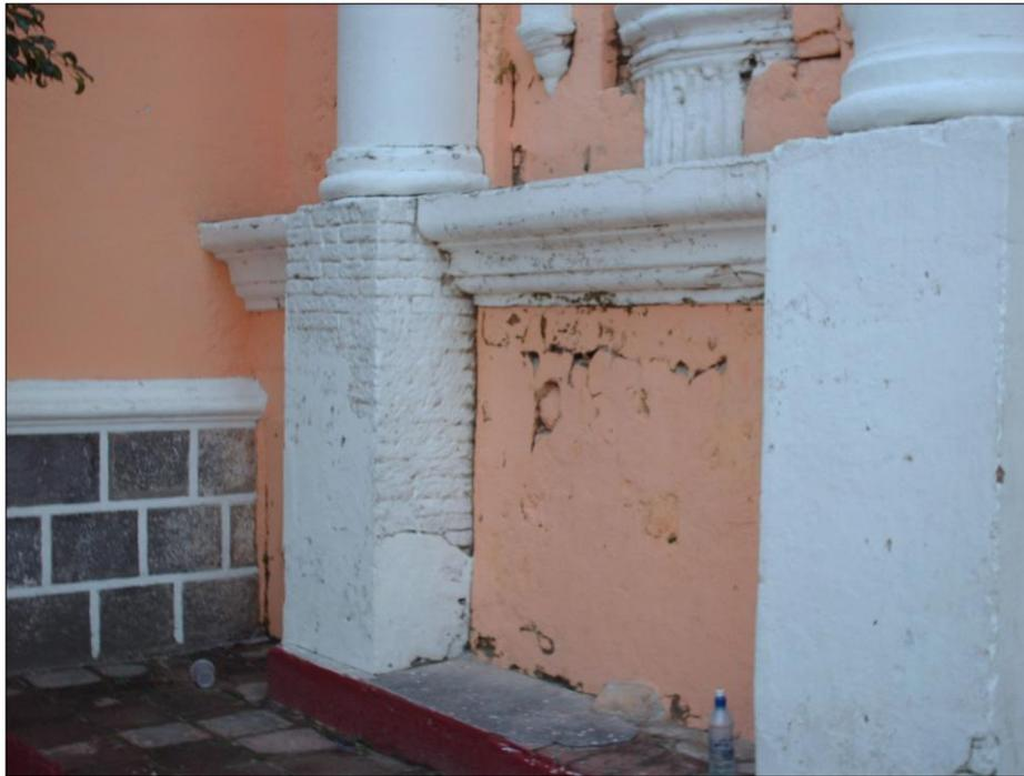
*Fotografía 34: desprendimiento de material en basamento de columna izquierda de la fachada.*
