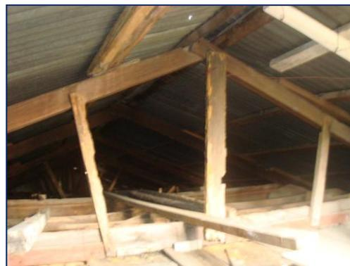
**Fotografía 31:** vista de la estructura de madera que soporta el techo del templo
