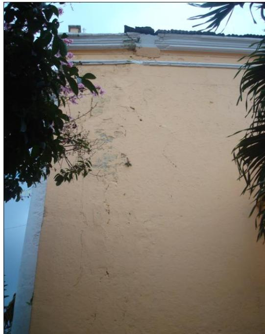
*Fotografía 35: desmoronamiento de material en la elevación derecha*
