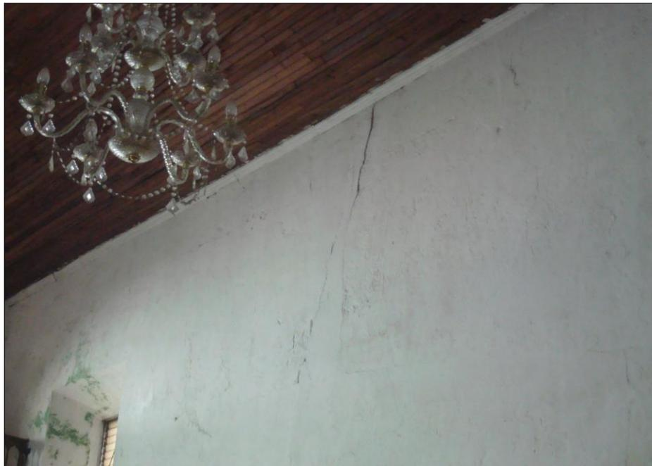
*Fotografía 42: fisura en muro lateral izquierdo*
