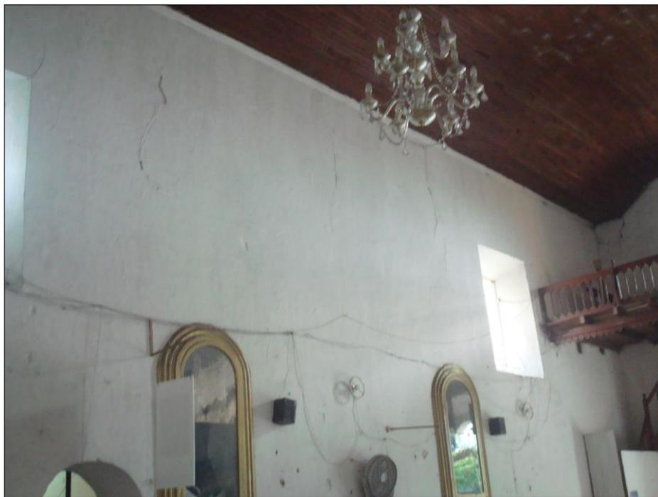
*Fotografía 43: varias fisuras en el muro lateral derecho.*
