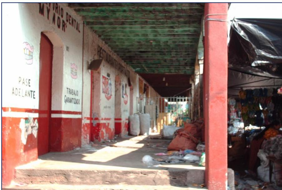
*Fotografía 19: vista interior del primer nivel del portal, como se observa todavía se conserva la estructura original de madera y los locales de ladrillo con revestimiento.*
