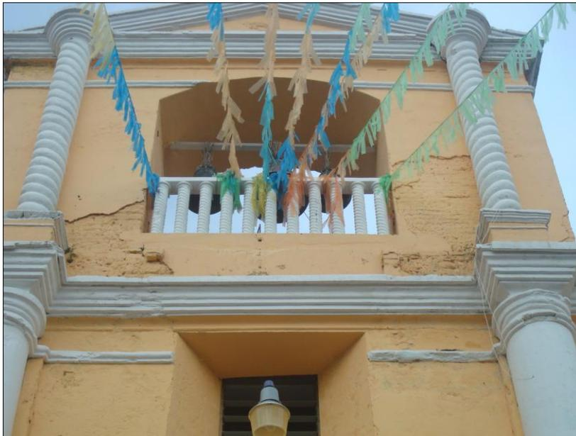
*Fotografía 32: se observa desprendimiento de material en la fachada*
