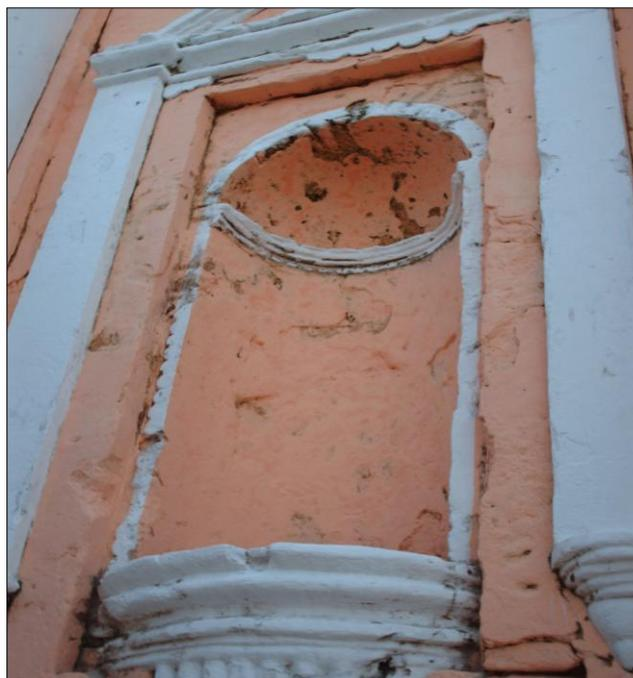
*Fotografía 33: vista de la hornacina izquierda, se observa desprendimiento de los acabados pudiéndose observar el material original de la construcción.*
