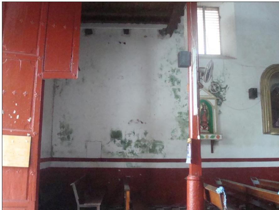
*Fotografía 37: manchas de humedad en el interior del templo en el muro izquierdo*
