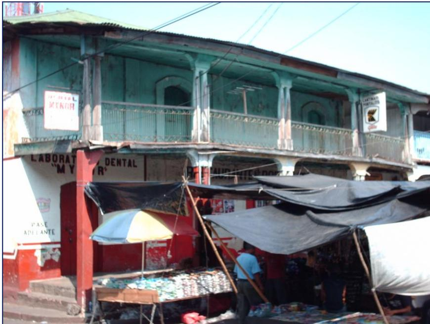
*Fotografía 18: vista del Portal observa que es una construcción antigua de madera y techo de lámina zinc*
