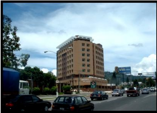
Ilustración 1 fuente Fotografía de edificio ibero plaza, conferencia Arq. Romeo Flores, Reglamentos y Normas de Diseño.
