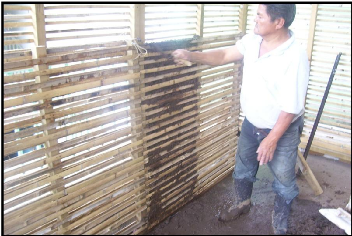
Fotografía de muro de bambú, guadua, relleno don terracemento.
