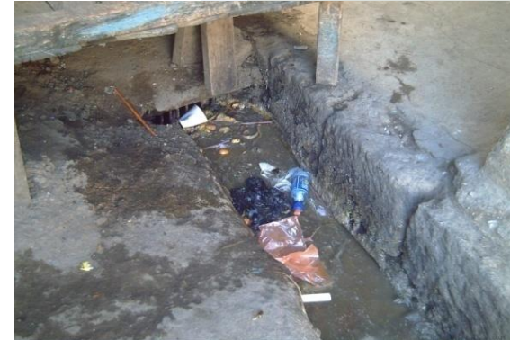
Ilustración 10: Interior Mercado Terminal
