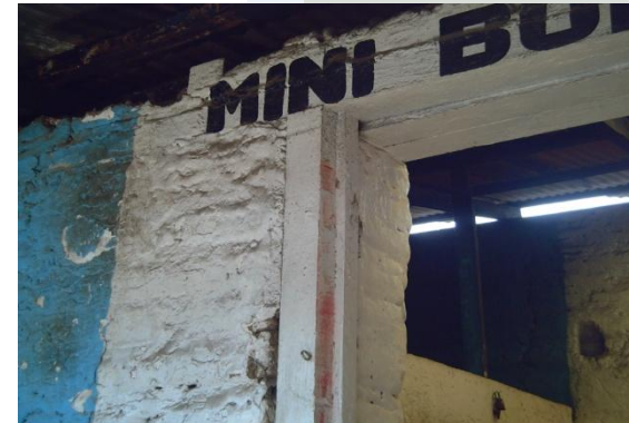
Ilustración 6: Interior Mercado Terminal
