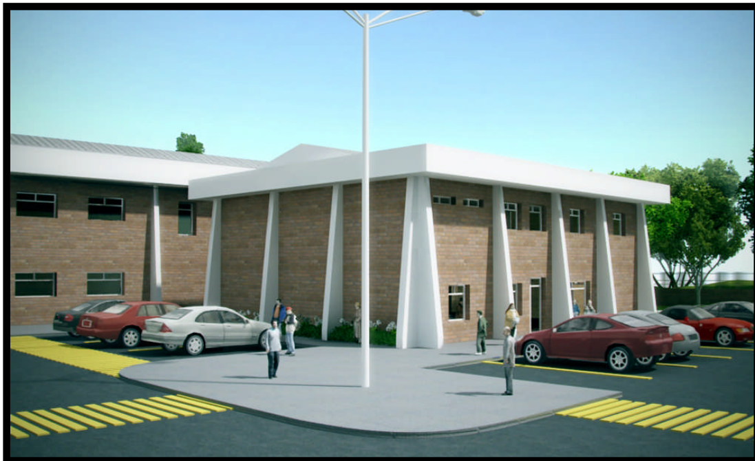
ÁREA ADMINISTRATIVA Y BIBLIOTECA
