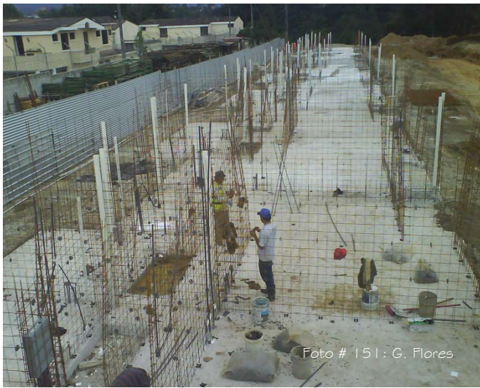
Colocación de separadores para formaleta. Preparación de la formaleta
