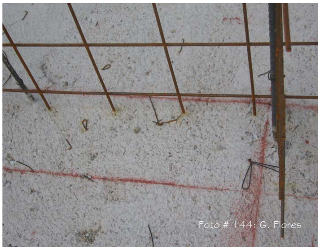
Marcaje de muros
