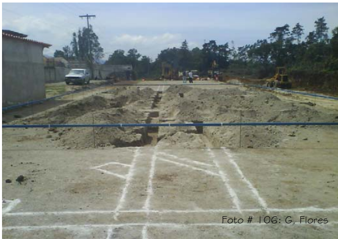
Marcaje y zanqueo para instalaciones
