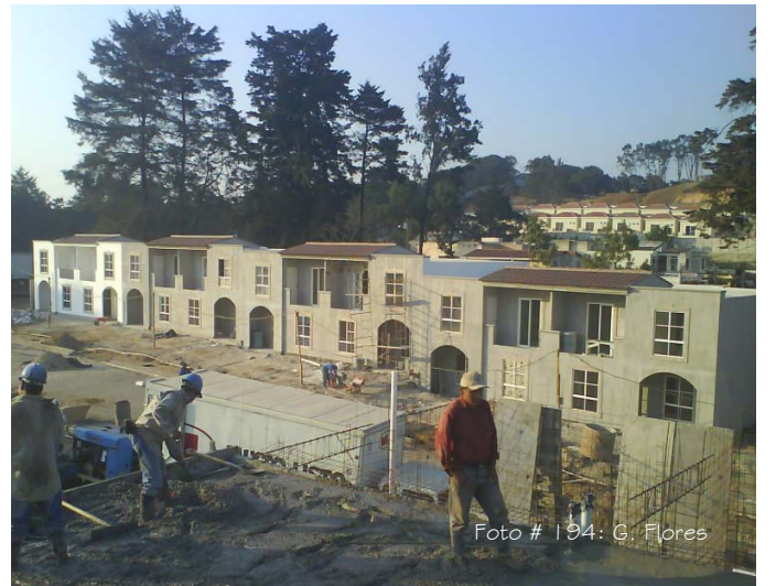
debe compactar siempre con el vibrador, procurando que sea homogéneo el trabajo.
