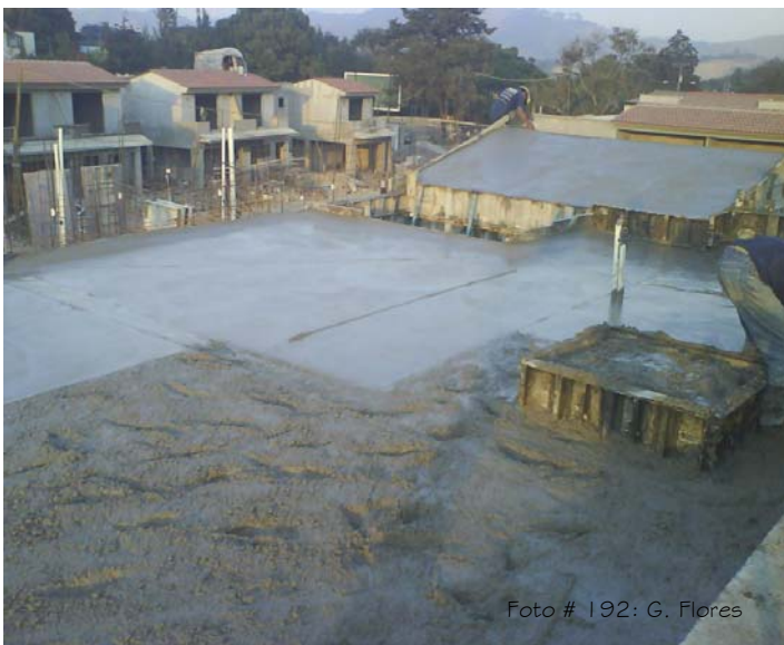
Distribuir en toda la losa el concreto,
