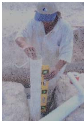
2. Colocar la tubería a plomo
