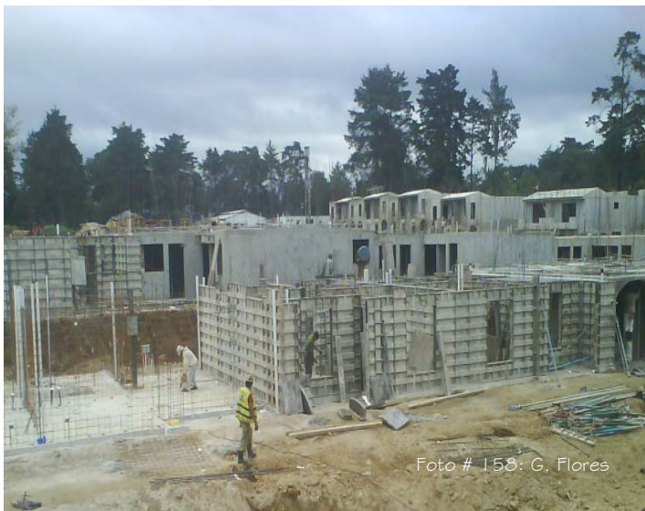
Armando Formaleta para muros 1° nivel
