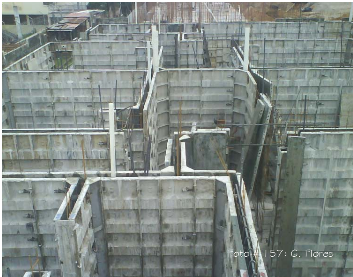
Armando Formaleta para muros 1° nivel
