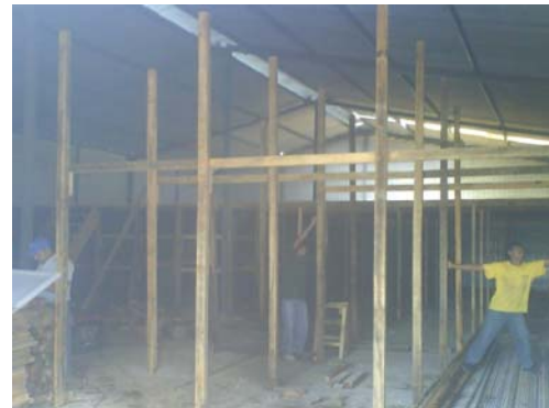
1. Secuencia de construcción de campamento
