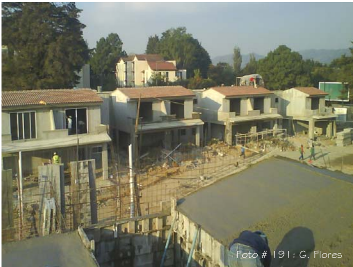
Distribuir en toda la losa el concreto,
