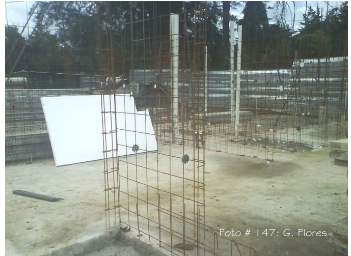
Colocación de electromalla
