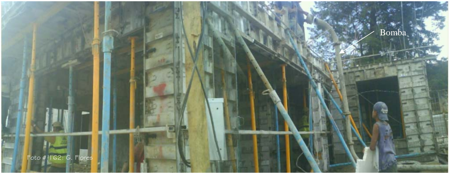
Fundición de losa de Entrepiso
