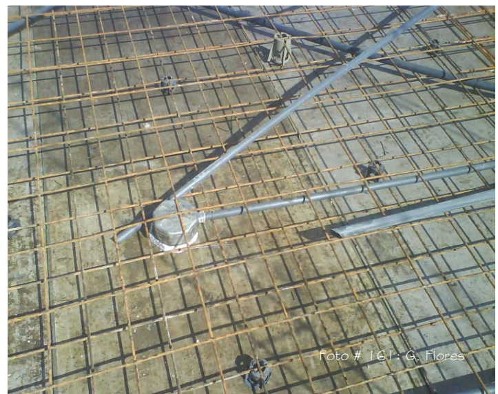
Armadura de losa de Entrepiso e Instalaciones
