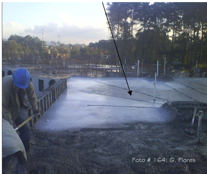
Distribución del concreto en entrepiso Abajo delineando los pañuelos
