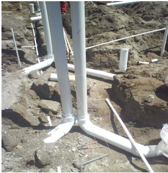
Foto # 111 Colocación de instalaciones Drenajes
