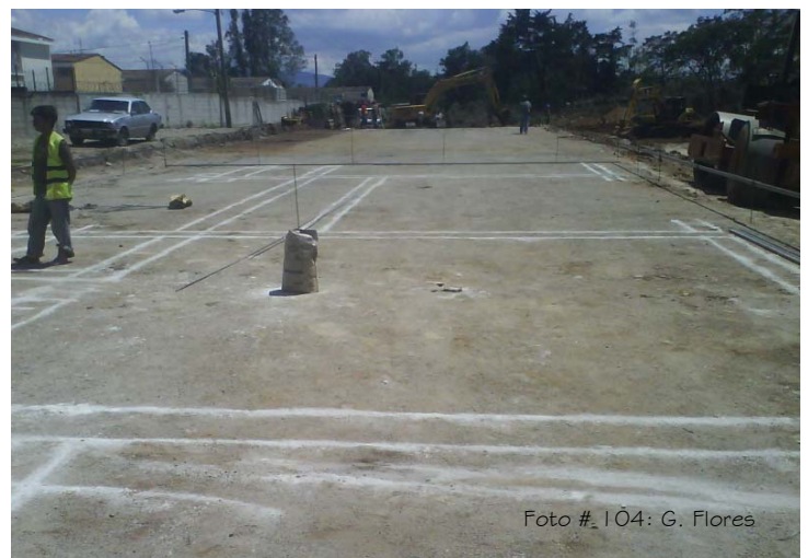
4. Trazo y Marcaje de Cimentación
