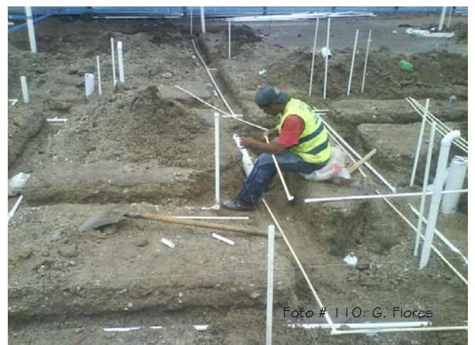
Instalación de tubería para agua potable
