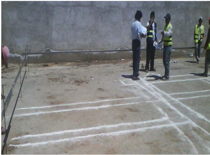
-Verificación de trazo por instalaciones
