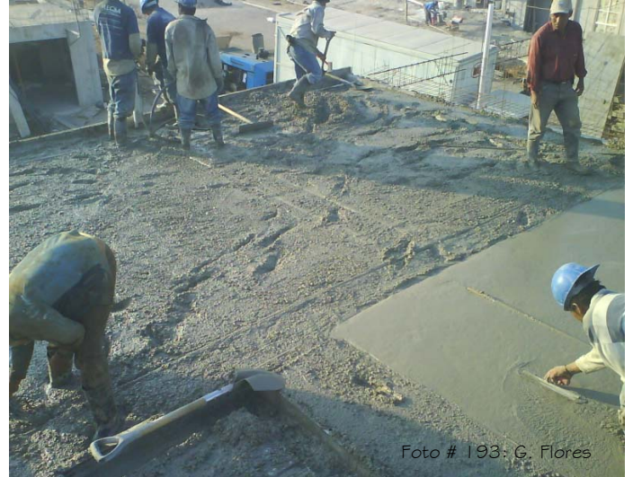
En los muros ya penetro el concreto y se
