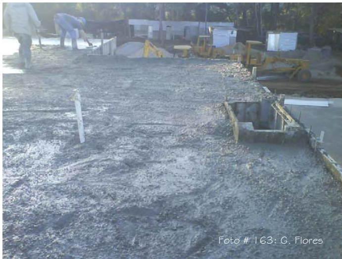
Distribución del concreto en entrepiso Abajo delineando los pañuelos
