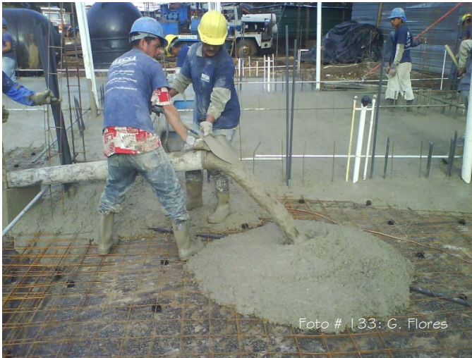
Vaciado del colado,
