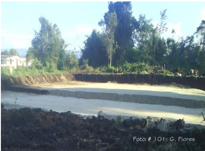
1. Compactación de terraplén
