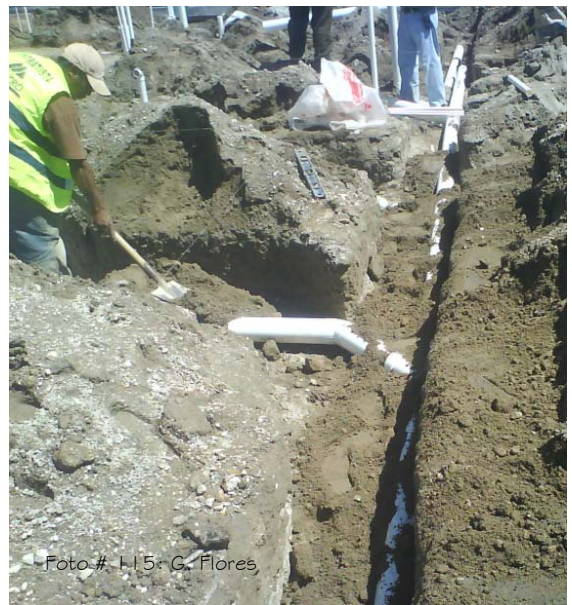
Las zanjas por donde viajan las instalaciones
