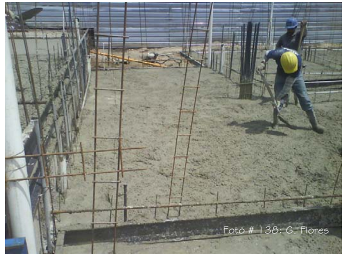
Llenado del perímetro de la cimentación.
