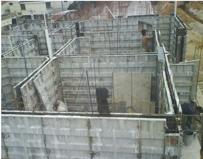
Foto 156. La Formaleta se empieza armar por la esquina Lateral Derecha de la vivienda,
