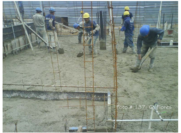
Llenado del perímetro de la cimentación.
