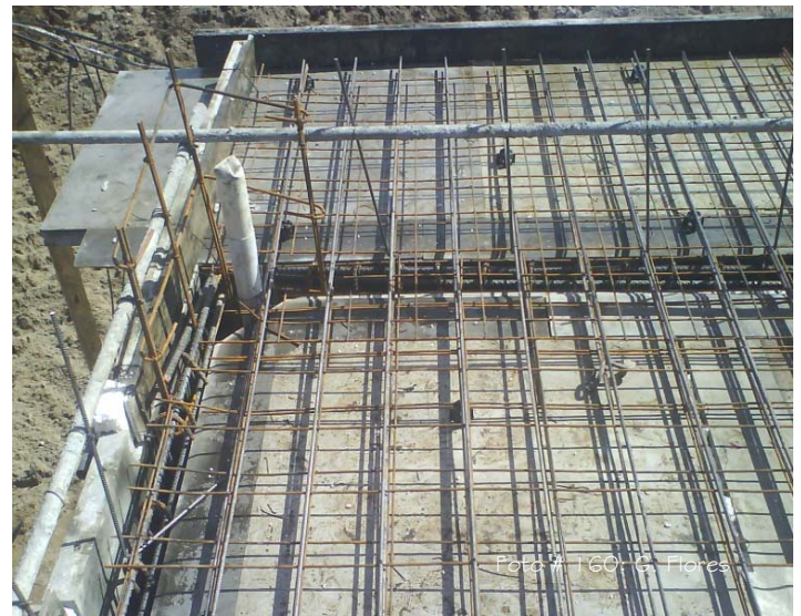
Armadura de losa de Entrepiso e Instalaciones
