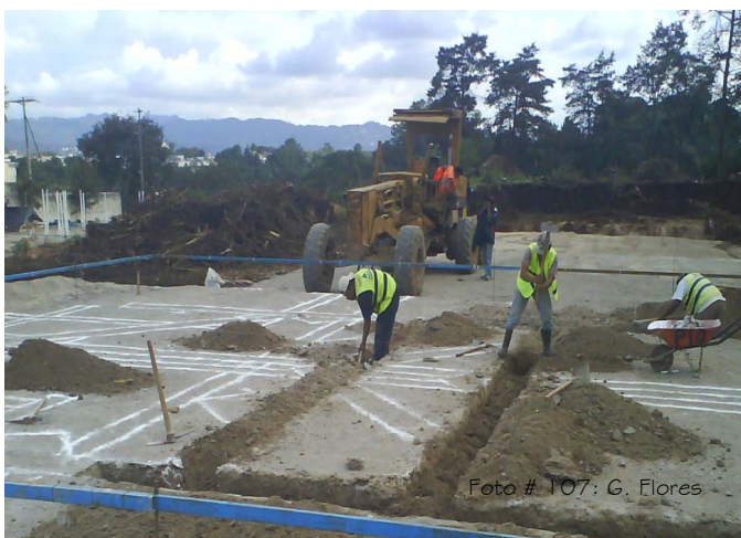
Marcaje y zanqueo para instalaciones
