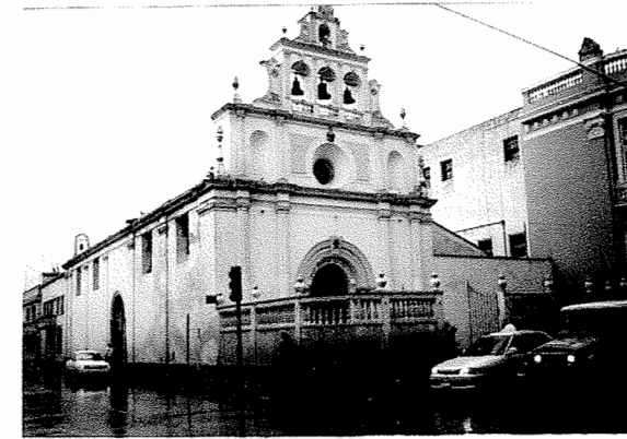
Capellanía Beatas de Belén año 2000. Aún conservaba el techo de lámina de zinc y su estructura de madera. Fotografía Delhy López Sánchez
