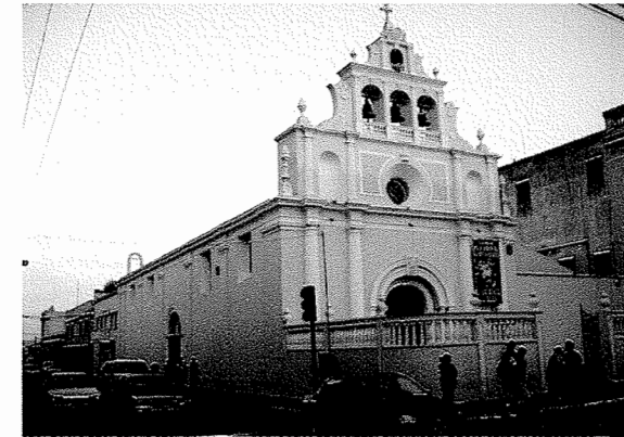
Capellanía Beatas de Belén año 2007. Su cubierta fue cambiada en Octubre 2000 por la Constructora ADYCO. Ing. Jaime José Santisteban Bethancourt. Fotografía Delhy López Sánchez
