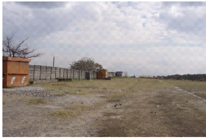
campos de futbol existentes en mal estado
