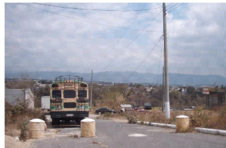
2. NO HAY BANQUETAS PARA LA SEGURIDAD PEATONAL
