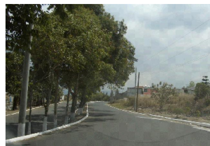
4. ACCESO POR LA 22 AVENIDA (VIA SECUNDARIA)
