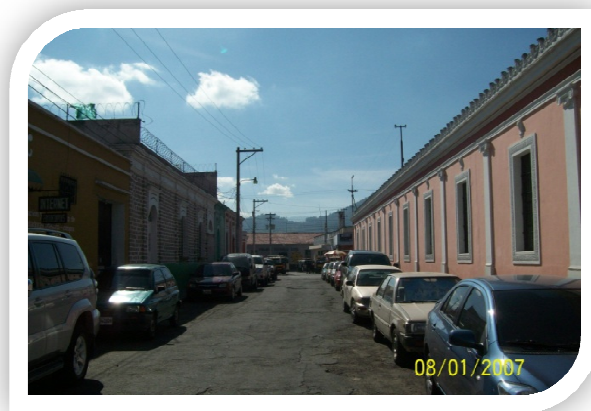
Foto No. 4: Se observa el estado de la calle de asfalto, y el parqueo vehicular en ambos extremos.
