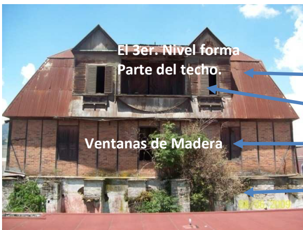
Vista de la elevación norte del edificio en estudio. FUENTE: Elaboración propia año 2009
