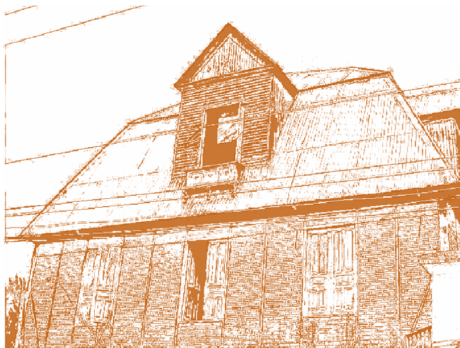
Edificio de Almacén de Granos del Antiguo Hospital de Occidente
