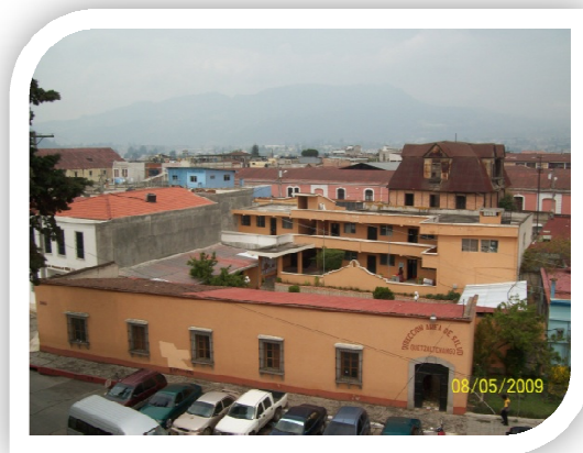
Foto No. 6: Vista aérea del conjunto de la Dirección del Área de Salud y la ubicación del edificio antiguo en el conjunto.
