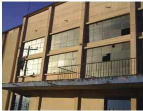
FOTO No. 1 CONTENIDO: Fachada Principal gimnasio "Mario René Aguilar" FUENTE: Elaboración Propia.
