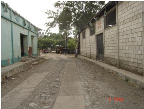
Las construcciones predominantes en la aldea son de block visto, y en algunos casos con acabados de cernido. Foto: O. R. Ajanel León
