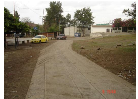
Final de Calle Principal Fuente Propia Foto: O. R. Ajanel León
