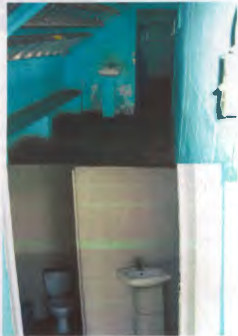
Foto N°20 Vista de los servicios sanitarios actuales del Polideportivo.
