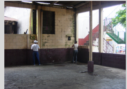
Imagen 32. Salón Municipal. Fuente: Visita de campo
