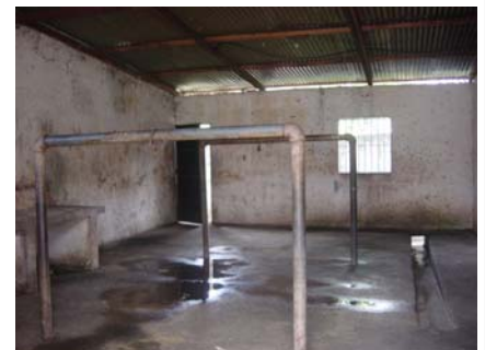
Imagen 54. Interior del Rastro Municipal. Esta vista muestra el interior del rastro municipal. Dentro de él se puede observar el pequeño canal que conduce los desechos directamente al río Cutzamá. El rastro se reubicará y se planificará de una forma adecuada, a manera que los desechos sean tratados correctamente.
