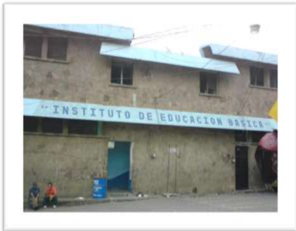
Fotografía No. 2 Ingreso posterior Ingreso a aulas de ENBI
