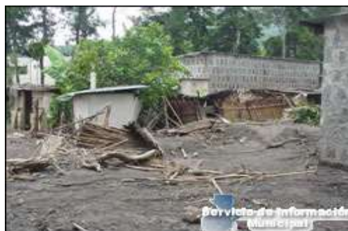
Fotografía No. 3 Viviendas después del paso de la tormenta Stan en Cantón Tzanchaj
