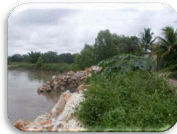
ESCOLLERA BARRIO EL ROMOLINO FOTOGRAFÍA 1.10: F.1 Se observa las escolleras que han sido hechas por la Municipalidad para prevenir la erosión del suelo
