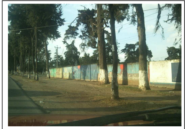
Fotografía No. 2-1 > Frente del Estadio Municipal de Chimaltenango, muro perimetral paralelo a carretera que conduce a San Andrés Itzapa.
