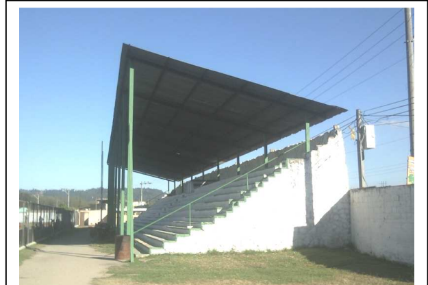
Fotografía No. 8. Vista lateral de la tribuna principal construida de piedra bola, además estructura metálica que sostiene el techo de lámina.
