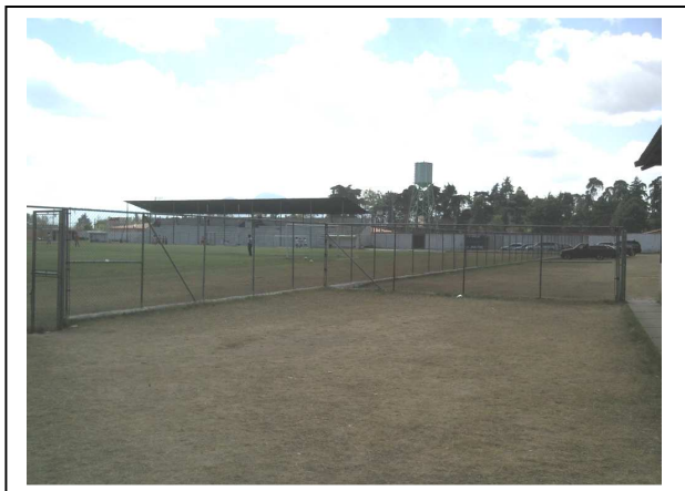
Fotografía No. 7. Malla interna perimetral del campo de fútbol, al fondo se observa la tribuna principal.
