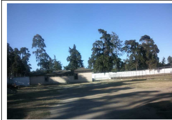
Fotografía No. 5. Vista lateral de la "Casa de la Cultura, interna dentro del área del estadio municipal.
