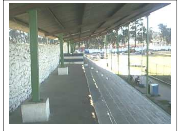
Fotografía No. 12. Vista de la tribuna principal. Nivel +3.80. Se ven las bases de las columnas que sostienen el techo de lámina.
