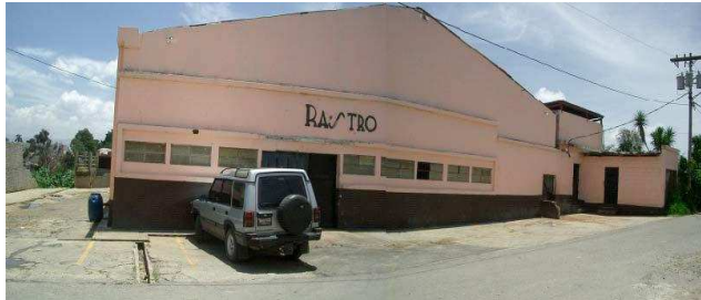
FOTOGRAFÍA IMAGEN DEL RASTRO MUNICIPAL
