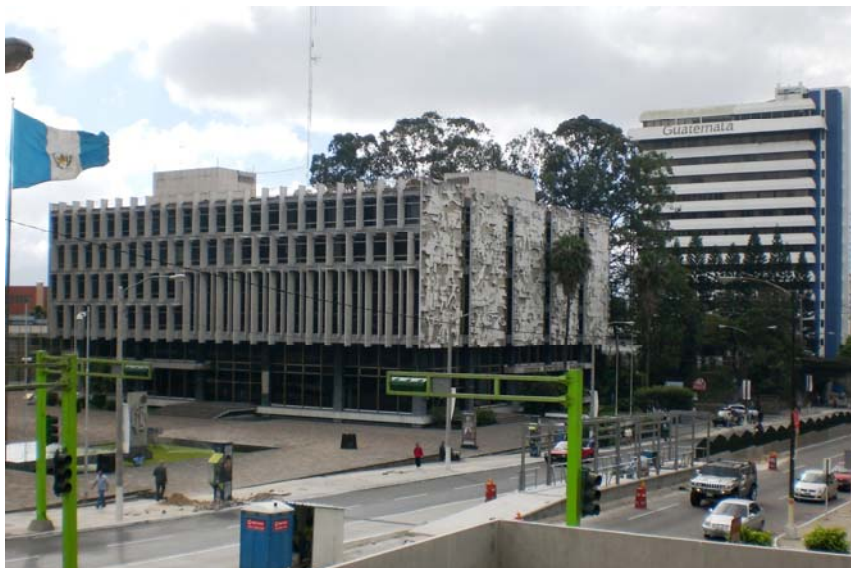
Entorno del mural del edificio del Crédito Hipotecario Nacional
