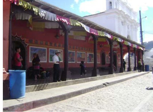
Imagen 13. Edificios al lado Este de la plaza de Chichicastenango. Fuente: Imágenes propias.
