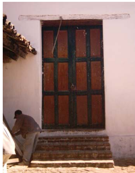
Imagen 46. Puerta en salón contiguo a la sacristía. Fuente: Fotografía propia. Archivo Fotográfico Ejercicio profesional Supervisado 2008-2009.
