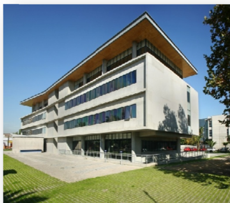
IMAGEN 23. Perspectiva del edificio. Lo interesante es el manejo de ventanería en la fachada longitudinal, mientras que la fachada transversal está completamente cerrada, por motivos de soleamiento y para obtener efectos visuales agradables desde el interior. Fuente: www.plataformaarquitectura.cl .
