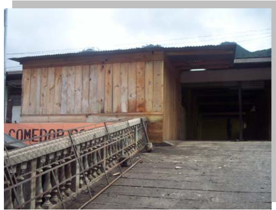
Foto 2. VISTA DE ESTADO ACTUAL 2DO. NIVEL
