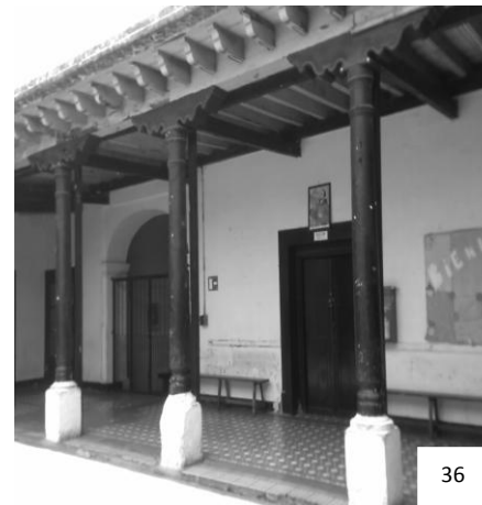
- Imagen No. 36 - Se observa el patio rodeado de corredores con el predominio de la línea vertical y horizontal dado por las columnas y vigas del techo.
