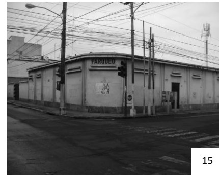
CONTAMINACIÓN VISUAL PROVOCADA POR CABLES ELÉCTRICOS, TELÉFONICOS Y CAJAS DE TELEFONÍA, SOBRE LA ESQUINA DE LA 10ª.CALLE - AVENIDA SUR.
