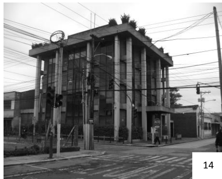
FOCO DE CONTAMINACIÓN VISUAL DE CABLEADO ELÉCTRICOS SOBRE, LA 4ª. AVENIDA Y 10ª CALLE.
