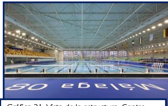
Gráfica 31. Vista de la estructura. Centro Deportivo Acuático de Málaga.
