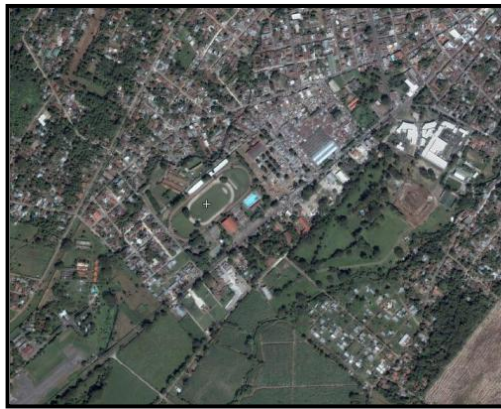
Zona Cuatro de Retalhuleu
