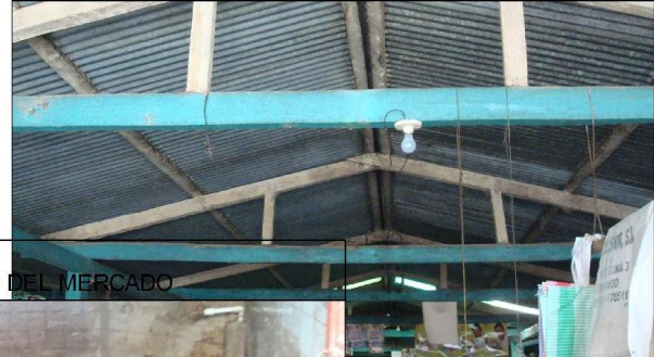
IMAGEN No. 12 VISTA DE ESTRUCTURA DE MERCADO ACTUAL
