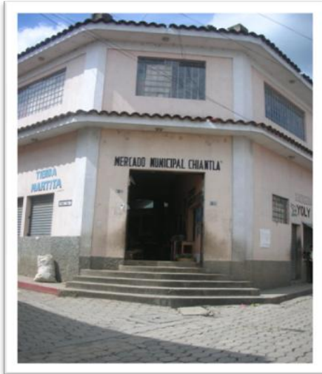
IMAGEN No. 14 VISTA DE INGRESO PRINCIPAL
