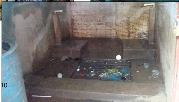
IMAGEN No. 13 VISTA DE INSTALACIONES DEL MERCADO
