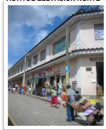
IMAGEN No. 15 VISTA DE ELEVACIÓN NORTE
