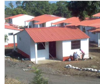
ACTUAL VIVIENDA MINIMA CHUKMUK SECTOR No. II, III, IV. CASAS YA CONSTRUIDAS 31% Y EL RESTO EN PROCES DE CONSTRUCCIÓN
