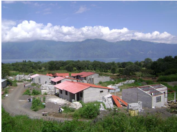
Proceso constructivos de las viviendas del Sector No. II
