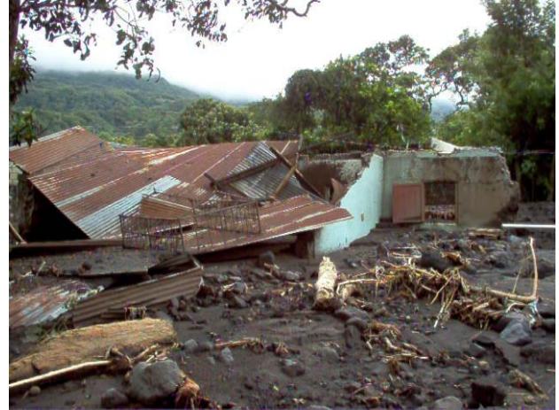
F29 Aquí se muestra el nivel de lodo que inundó las viviendas y el desastre que ocasionó
