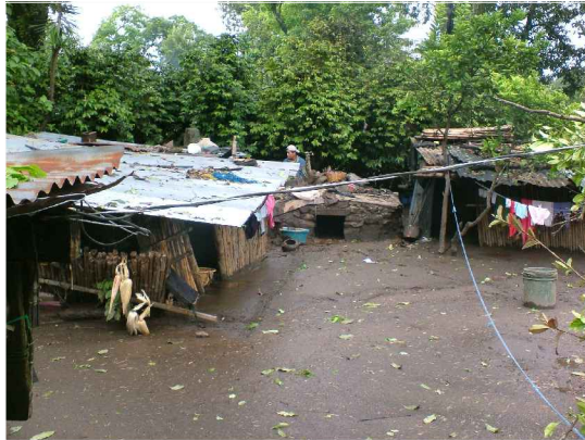
VIVIENDAS DEL CANTON DE PANABAJ DE TARRO Y LAMINA SE OBSERVA EL NIVEL DE LODO QUE DAÑO LAS VIVIENDAS
