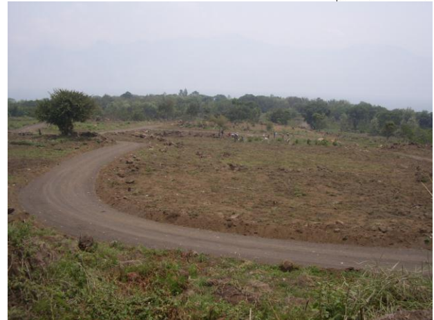
Chukmuk Sector No. II, Limpieza de terreno para el inicio de construcción de las viviendas
