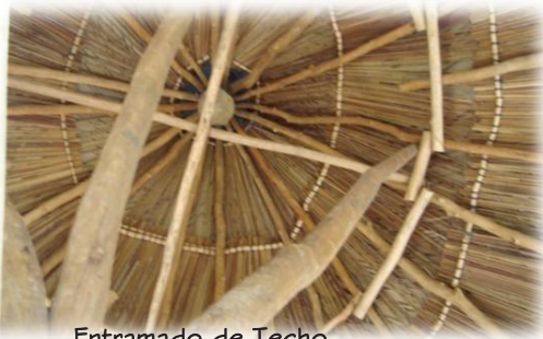
Entramado de Techo
