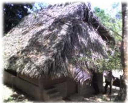
Vivienda, Comunidad Creek Cáliz Fotografía No. 5 Fuente: propia
