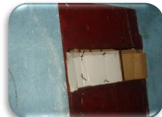
PUERTA DE INGRESO CARCEL
