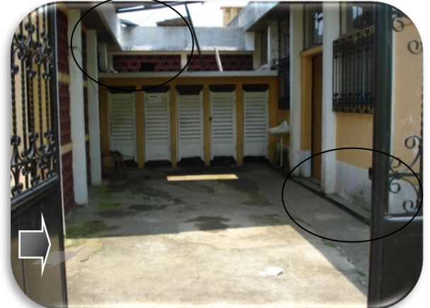
CANAL AGUAS NEGRAS HACIA CALLE PRINCIPAL
