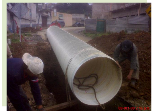
Foto No. 10 Entubamiento de red de sistema de agua servida.
