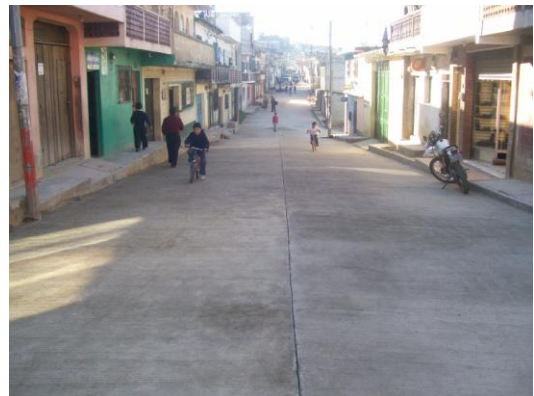
Foto No. 21 se aprecia las viviendas dentro del área urbana que van desde 1 y 3 niveles.
