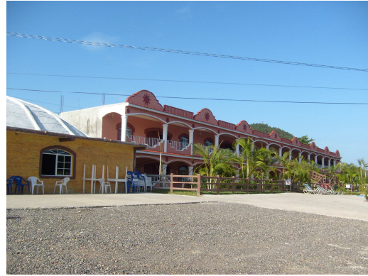
Fotografía No. 24 Salón de Convenciones
