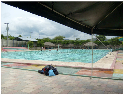
Fotografía No. 18 Piscina Olímpica
