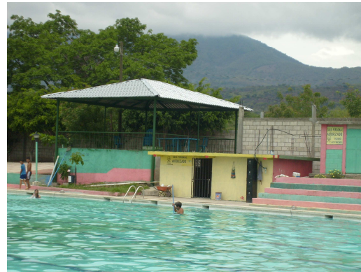
Fotografía No. 19 Cuarto de Maquinas
