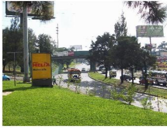
01 km. 16 C-A1, carretera al altiplano imagen no. 14 fuente: elaboración propia
