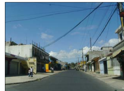
FOTOGRAFÍA 8: CALLE DE SALIDA DE COLONIA PLANES DE MINERVA, ASFALTADA. ELABORACIÓN PROPIA
