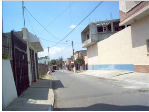
IMAGEN 14 VISTA HACIA LA CALLE, PREDOMINA VIVIENDA FAMILIAR, ALTURA PROMEDIO DE LAS VIVIENDAS 5.50 METROS. ELABORACIÓN PROPIA.
