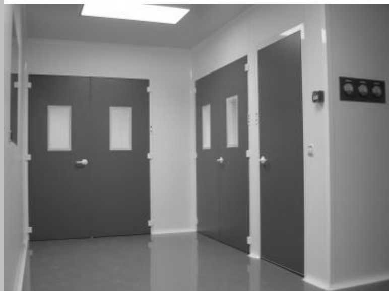
Gráfica 4.15 Puertas en Sistema Modular Fuente: Esquema de Elaboración Propia, Fotografía Puertas Salas Limpias Imágenes Google.
