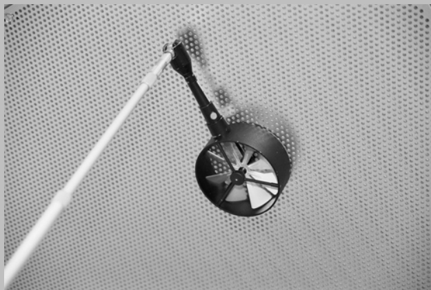
Gráfica 4.51 Test de velocidad del aire acondicionado, Proceso de Cualificación de la Instalación
