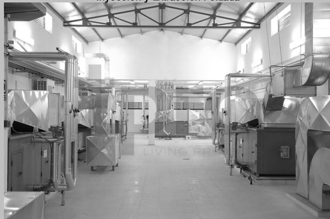
Iluminación natural de la zona técnica
