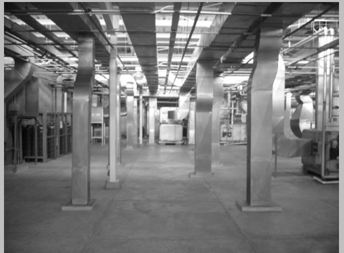
Ductos montados sobre la retícula de soportería
