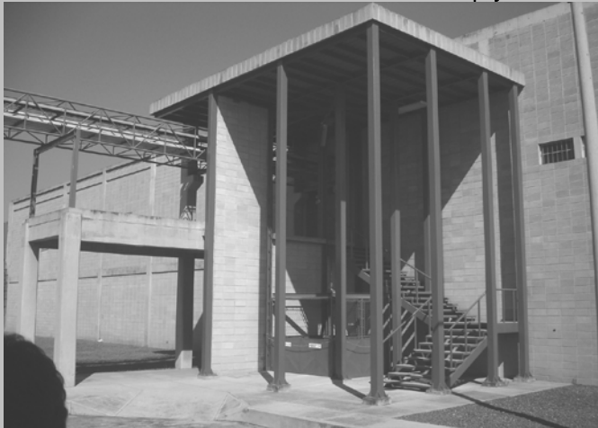
Modulo de Acceso y Montacargas a Zona Técnica de Servicios
