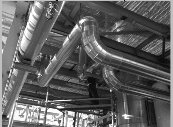
Conductos del sistema de climatización
