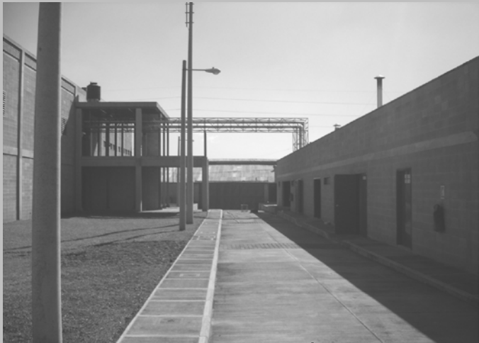
Izquierda, Zona Producción, Derecha; Área de Servicios, Relación Directa de Redes de Servicios de Apoyo
