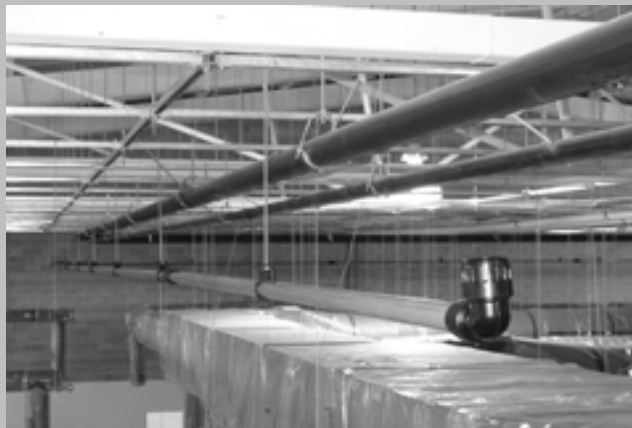
Gráfica 5.110 Ejemplo de circuito de distribución de aire comprimido, red cerrada.
