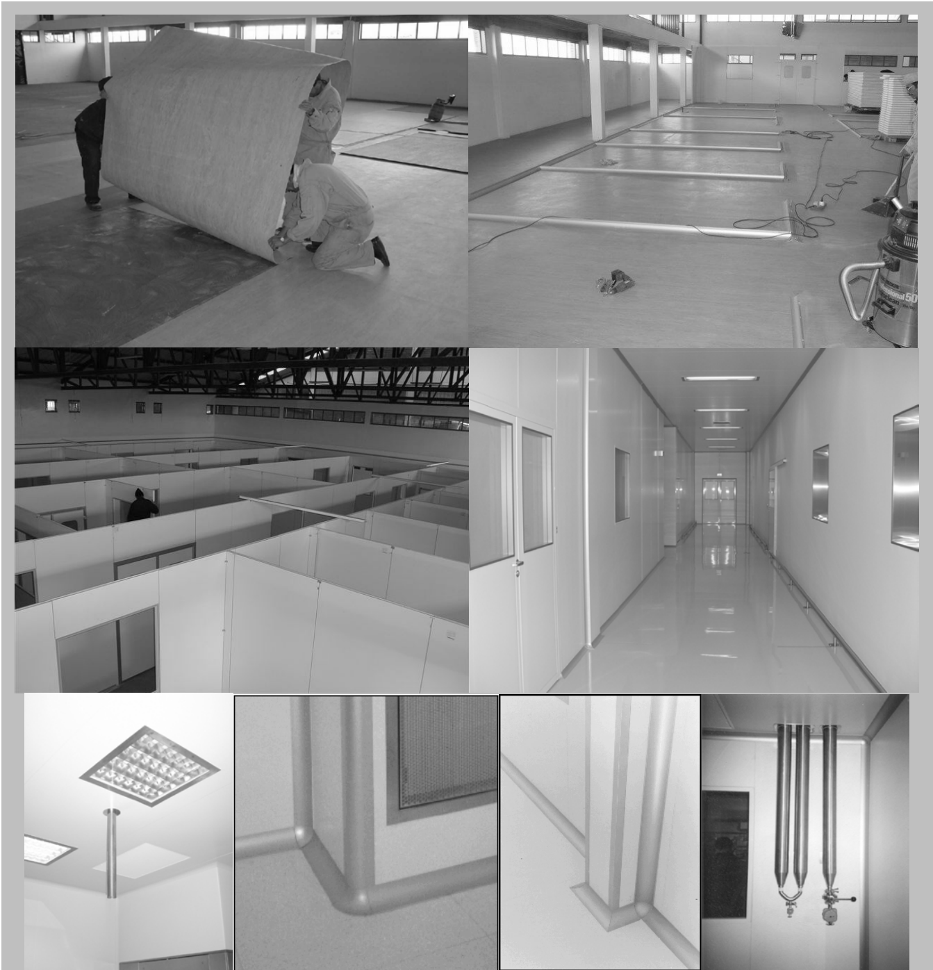
Gráfica 4.13 Proceso de montaje del sistema modular, Arriba, Izquierda; Instalación de piso de vinil de 3mm sobre base de concreto, Derecha, Fijación de perfiles para el anclaje de los paneles de resina fenólica que serán los cerramientos (paredes), en medio; Izquierda; Vista panorámica del montaje de paneles de cerramientos, Derecha, vista interna de un pasillo donde ya está terminado el proceso de montaje, Abajo, Detalles de Cielo con accesorios de suministro de servicios y luminarias, Detalles de curvas sanitarias y Detalles de Enchaquetado de Tuberías o Bajadas de Tuberías de Acero Inoxidable dentro de las Salas Blancas, con el fin de evitar desprendimiento de partículas y poder hacer más eficiente el proceso de limpieza,
