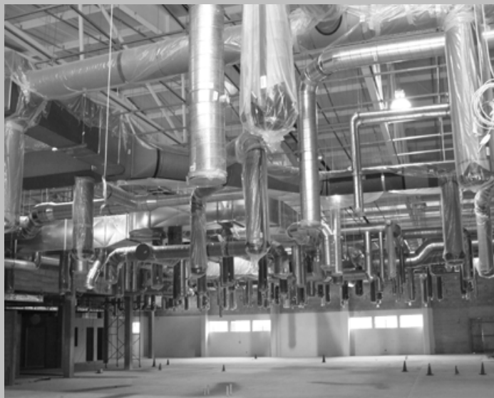
Gráfica 5.79 Esquema de canalización de aire tratado. Fuente: Aire acondicionado (climatización), Normas y Proyectos de Construcción, Tema 23.
