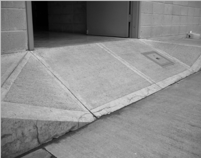
Rampas de servicio en cada sala
