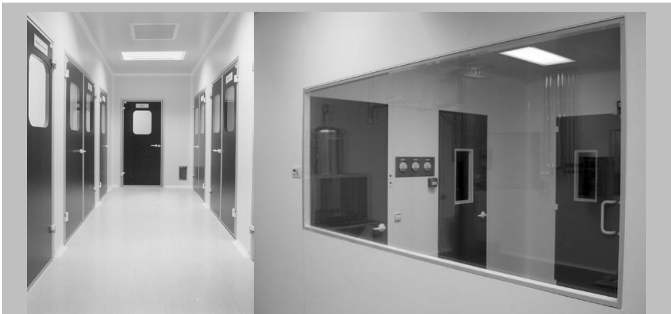
Gráfica 4.16 Puertas y Ventanas en Sistema Modular Fuente: Fotografías Puertas y Ventanas de Salas Limpias, Imágenes Google.
