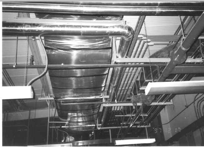
Ducteria y Tuberías simplemente apoyadas
