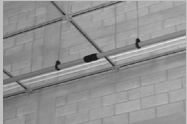
Gráfica 5.110 Ejemplo de circuito de distribución de aire comprimido, red cerrada.
