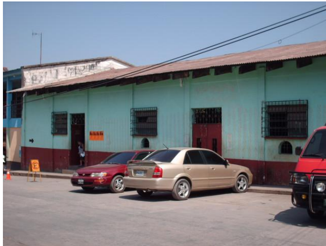
Foto No 6. Salón Municipal. Fuente: Propia.
