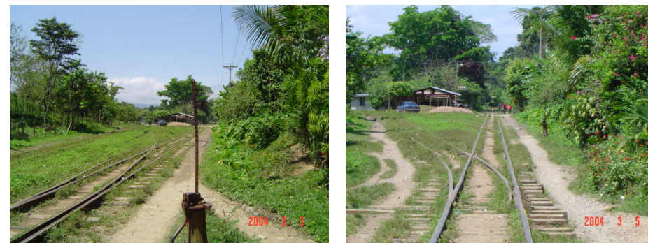
Fotografías No. 5 y 6 CAMBIO DE VÍAS Y SWICHT
