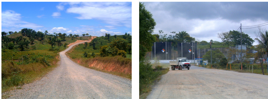
Fotografías No. 58 Y 59 ACCESO SECUNDARIO A PUERTO BARRIOS, CARRETERA A GENOR
