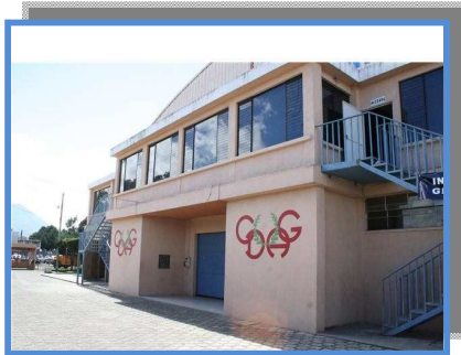
Foto No. 15. – Ingreso al Centro Deportivo Año 2009.
